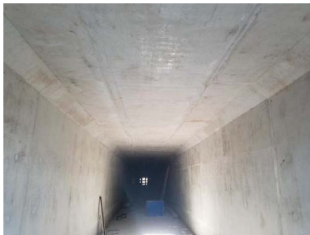
标准断管廊拆模后外观质量效果
