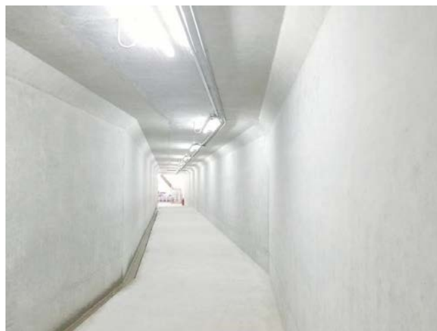
成品管廊外观质量照片
