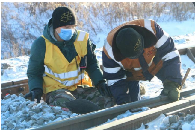
图2 铁路路基雪害处理
