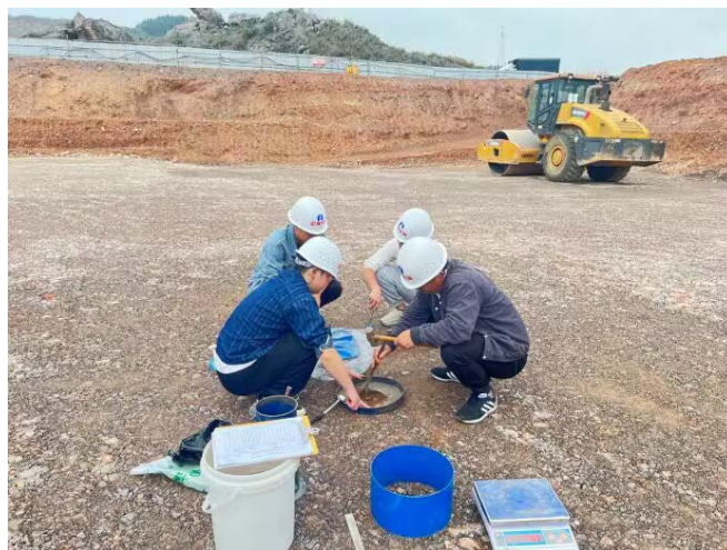
图3 地基检测现场图
