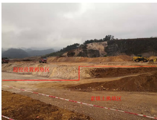
图2 地基处理现场图
