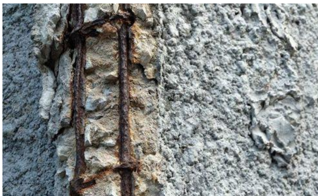
图1 钢筋锈蚀
