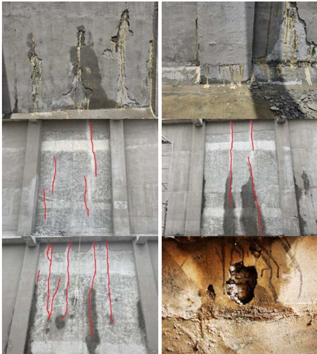
图2 水池外观质量缺陷典型照片
