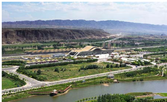
图1 “山-塬-水-林-城-站”相生共荣的中卫南站
