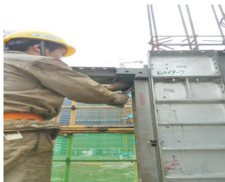
图2 梁侧模板安装
