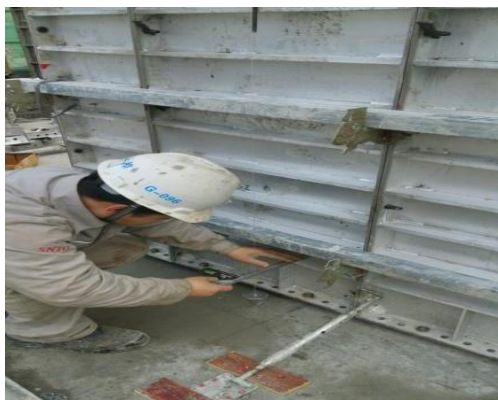
图3 墙柱垂直度检查
