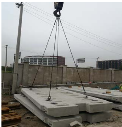
图2 预制板吊装
