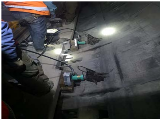
图5 预制板水平精调
