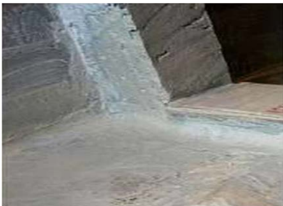
墙地阴角处需要用堵漏宝做平滑小圆角处理。
