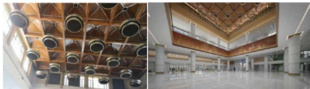
图8 既有南站房进站大厅原吊顶 图9 既有南站房进站大厅原吊顶改造
