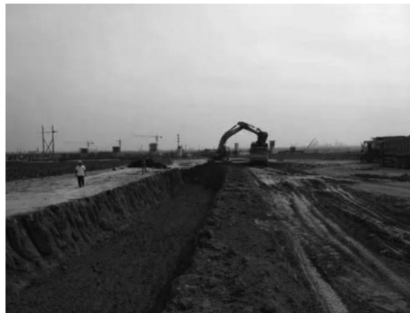
图1 道路低填浅挖施工
