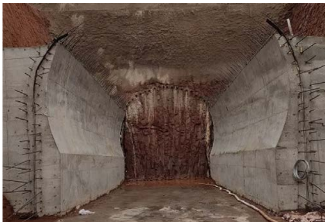
图5 TBM始发硐
