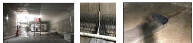
环形渗漏水防治体系做法及现场图
