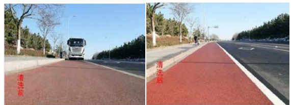
图8 砂基透水路面的清洗
