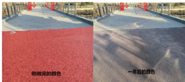
图1 罩面工艺的新做透水路面与一年后的颜色对比图
