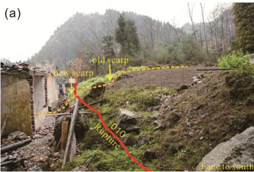
图4 北川—映秀断裂小鱼洞中坝村附近地表破裂观察点
