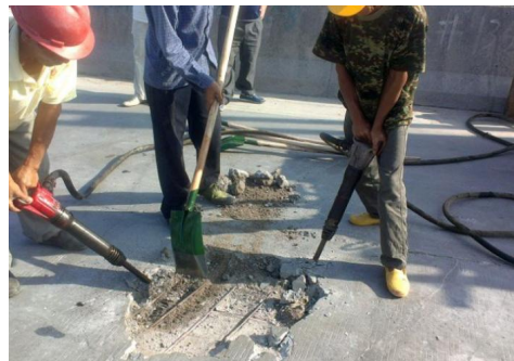
图3 道路桥梁混凝土路面裂缝修补
