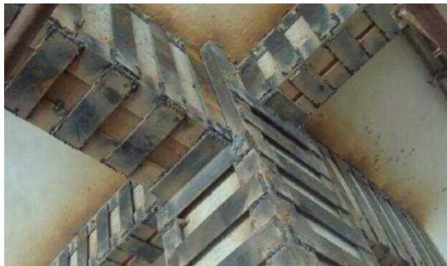
图2 外包与黏合钢筋加固
