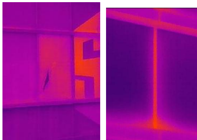
(a) 玻璃碎裂
