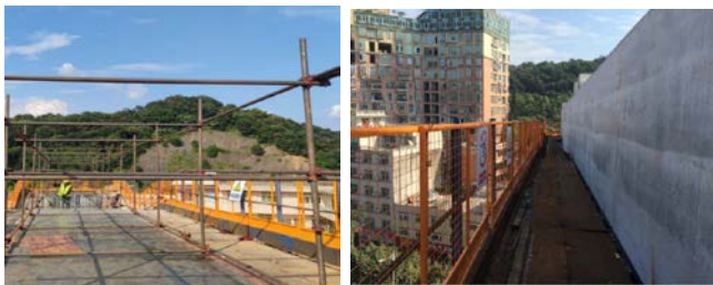
第三层防护棚板施工
