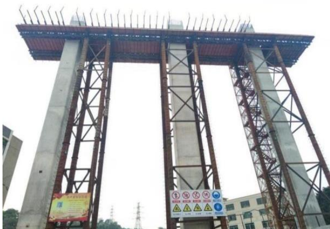
第二层防护棚板施工
