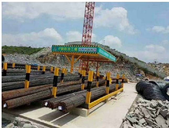
图1 建筑工程的材料堆放
