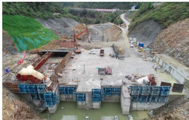
图2 泵站混凝土施工
