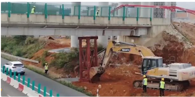
图2 临时支墩安装图
