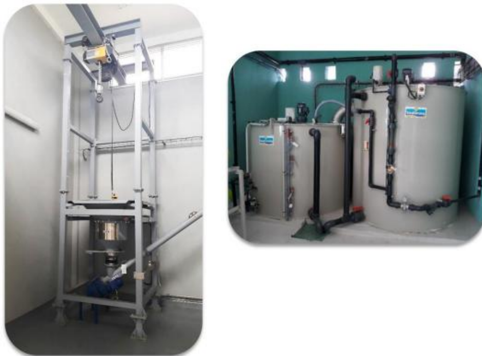
图1 粉体拆包上料和石灰乳液制作车间
