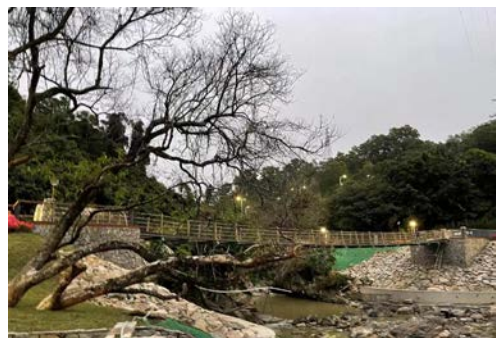
图6 鹏城大索桥实景图
