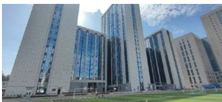
图1 建筑幕墙外观
