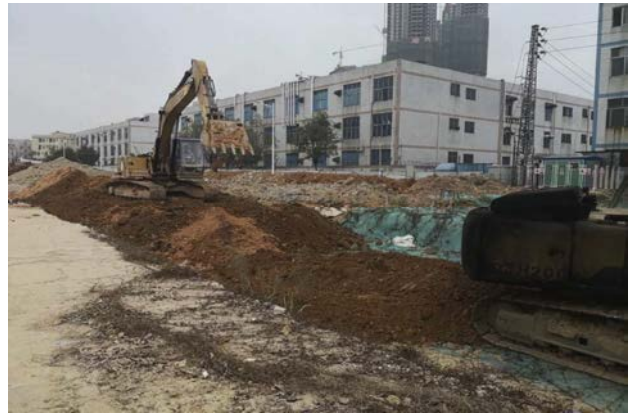
图1 软土路基换填开挖换填施工
