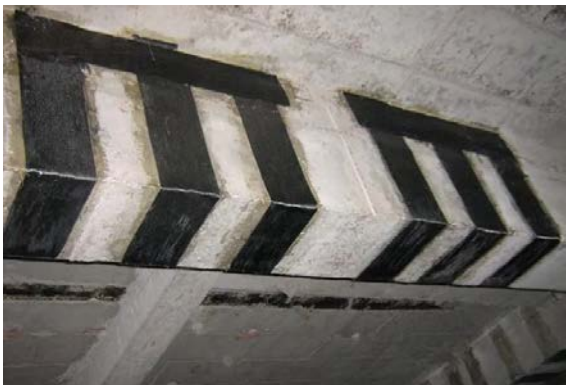
图1 碳纤维加固法施工现场举例图
