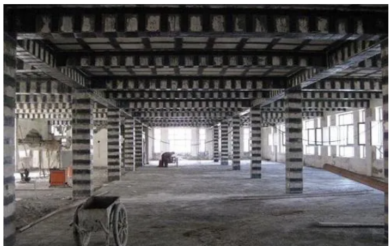
图2 植筋加固法施工现场举例图
