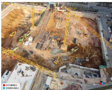
图3 惠通产业基地总部大厦基坑现场图
