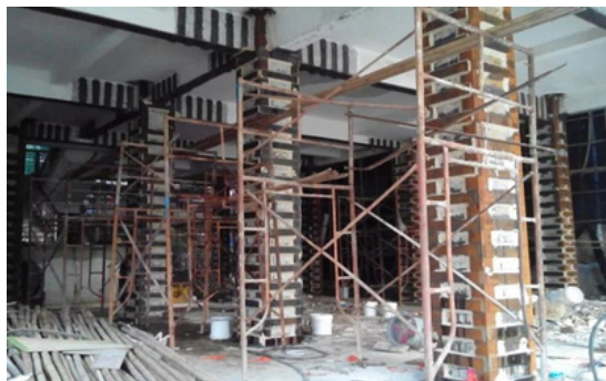
图1 建筑施工现场
