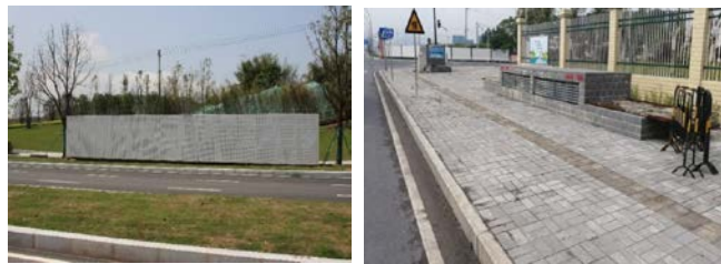
图2 已建综合管廊实景图
