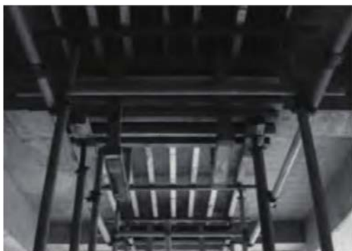
楼层后浇带支架模板预留图
