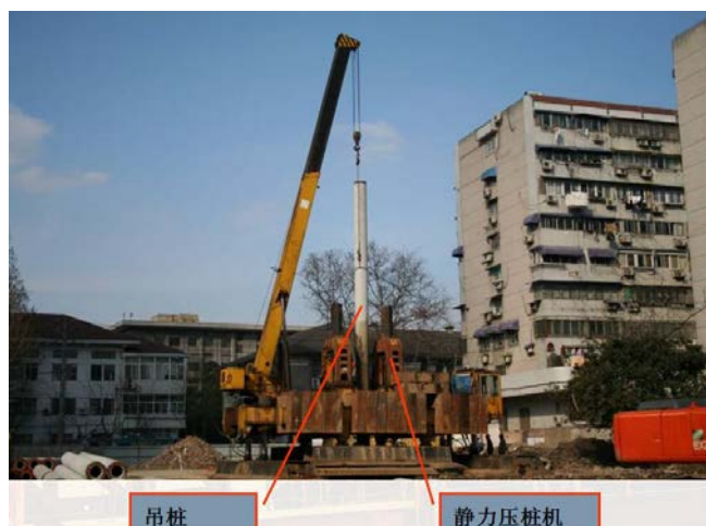
图2 静力压桩技术施工图
