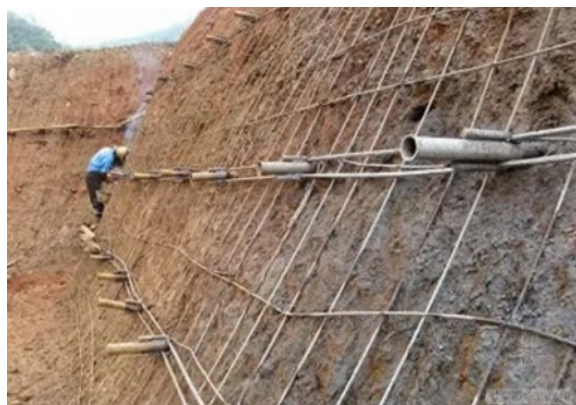
图1 土钉墙支护技术施工图
