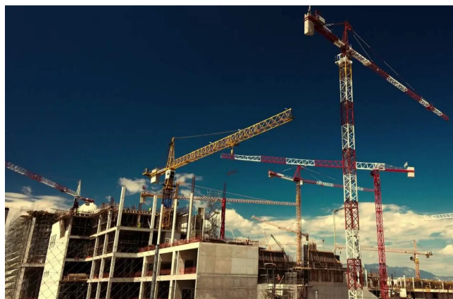
现代化建筑施工工程
