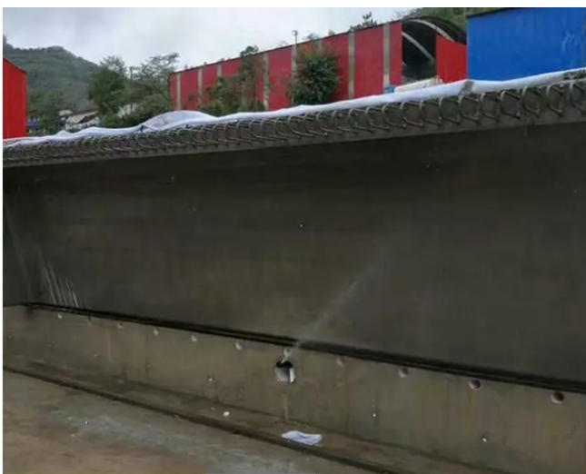
图2 预制T梁混凝土养护示意图
