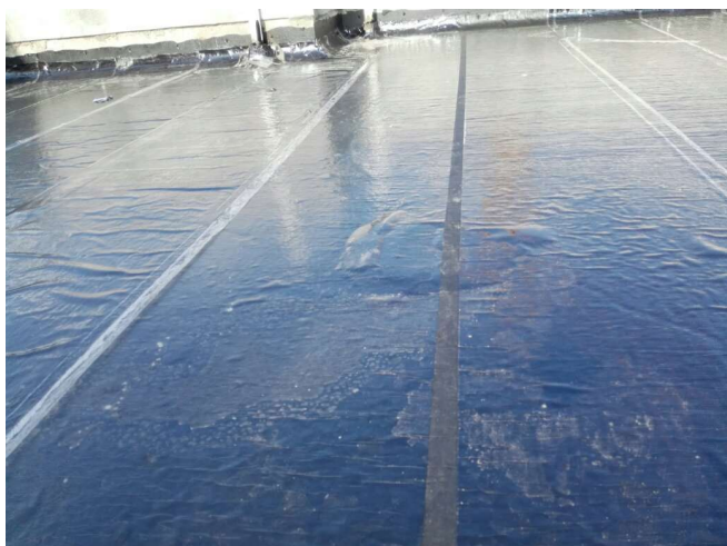
图2 柔性防水层局部空鼓、气泡图
