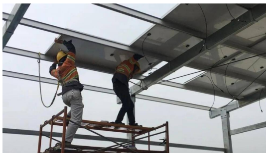
图1 光伏电站高空作业人员施工现场图
