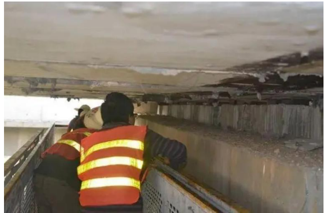
图二 桥梁加固
