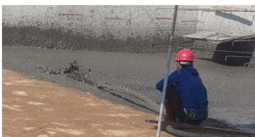
图4 泵送管出口与浇筑面成小角度浇筑
