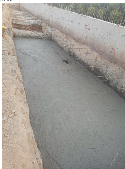
图3 施工区域分层浇筑
