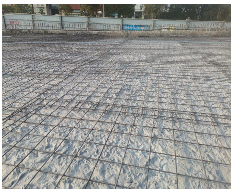
图5 金属网绑扎施工
