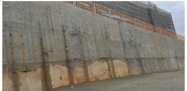
图6 复合挡土墙分段施工完成效果
