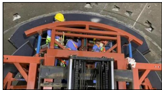
图5 顶板安装
