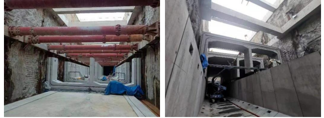
图5 现场下部及上部预制结构叠拼
