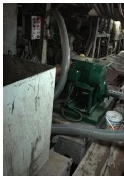
图4 洞内剪切泵循环拌制A料
