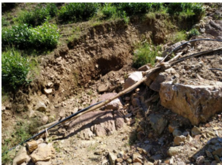
图3 岸带崩塌B2示意图
