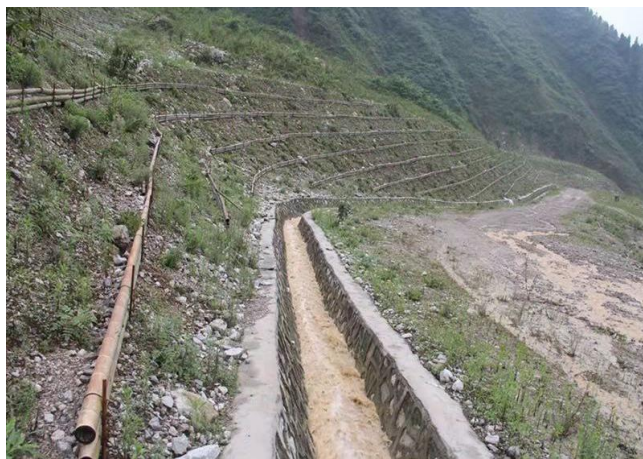
图5 竹格栏工程示例
