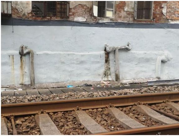
图1 污水直排支渠
