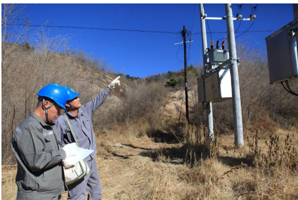
图1 电力基建工程巡查图
