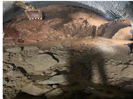
图6 YK73+696塌腔流砂、流泥
