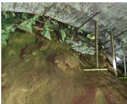
图8 码砌砂袋、竖向支撑
