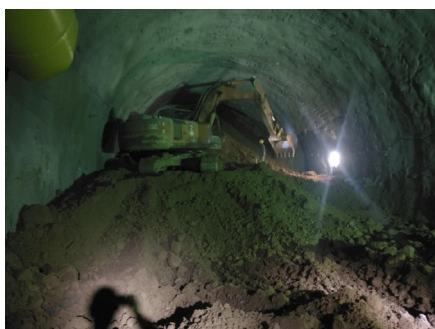
图7 反压回填掌子面
