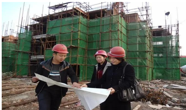
图1 为房建工程审核施工现场
