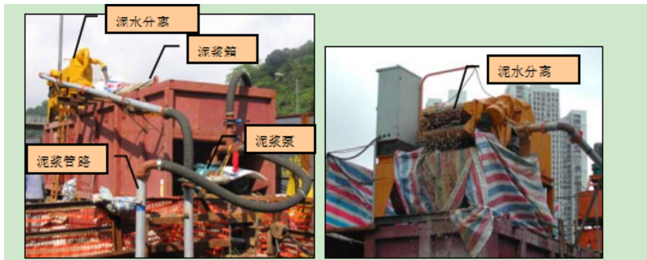
图1 泥水循环现场示意图
