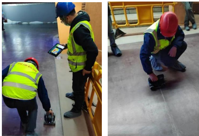
图5 结构雷达检测 图6 结构雷达检测
