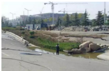
图1 南京地铁2号线元通站事故之地面沉降照片
